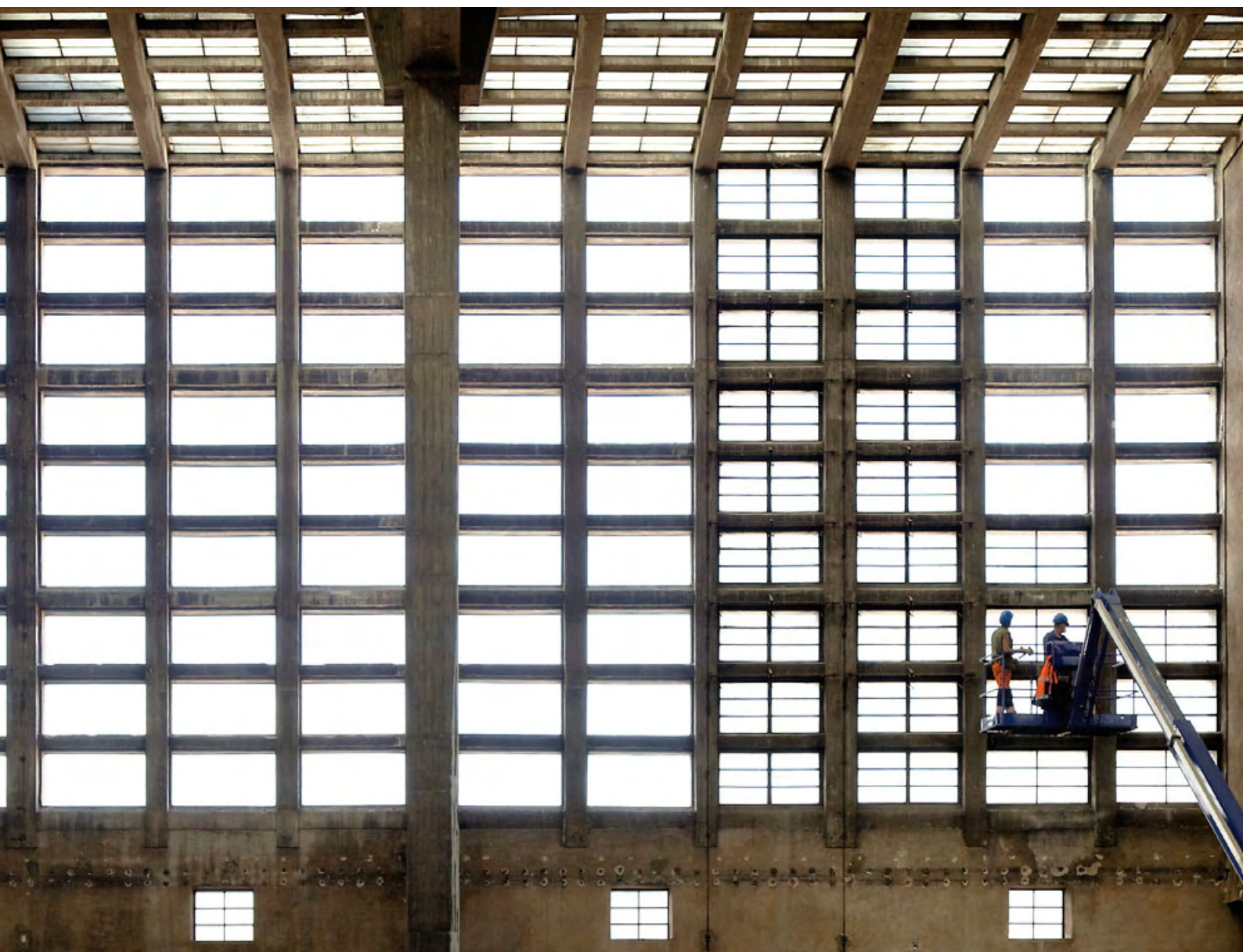
Betoninio tinklo pavidalo konstrukcijos fasado vaizdas iš vidaus. Grossmarkthalle pastato restauravimas yra svarbus statybos darbų aspektas. Svarbiausi pastato išorės elementai bus išsaugoti, o fasadai ir paviršiai bus restauruoti pagal pastatų išsaugojimo tvarką.
